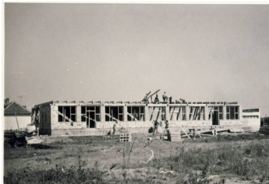
az óvoda építése
