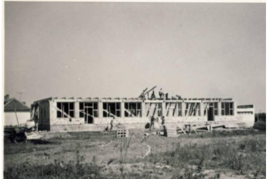
az óvoda építése
